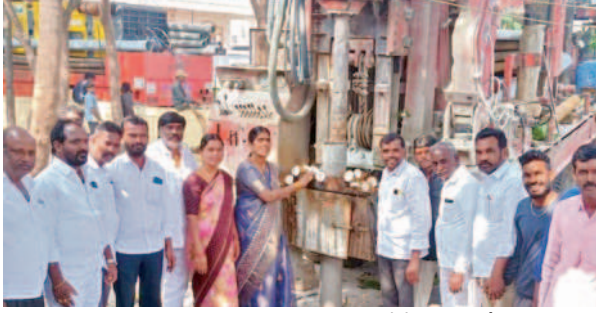
బోరుబావి పనులను ప్రారంభిస్తున్న ఎంపీఓ భాగ్యలక్ష్మిరెడ్డి
